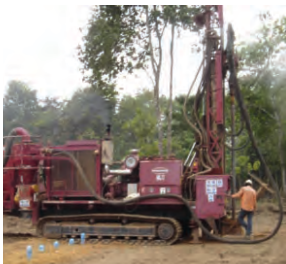
UXO Lateral Bore Hole
